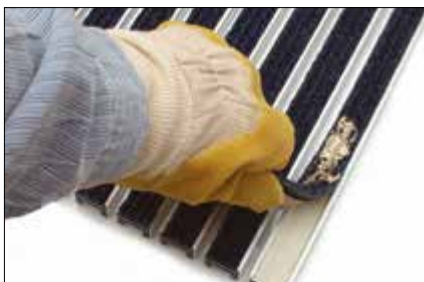
1. Bruk en vanlig flat skrutrekker for å løse Tekstil ilegget i den ene enden. Og riv opp ilegget i hele lengden som skal skiftes ut.
