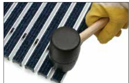
3. Fjern beskyttelsen på den dobbeltsidige tapen og vær nøye når du legger det nye ilegget på plass. Ta litt og litt om gangen. Press ilegget inn langs den ene siden av profilen først og så ned. Hvis nødvendig bruk en gummi hammer (eller forsiktig med den flate skrutrekkeren) for å få det skikkelig ned.
